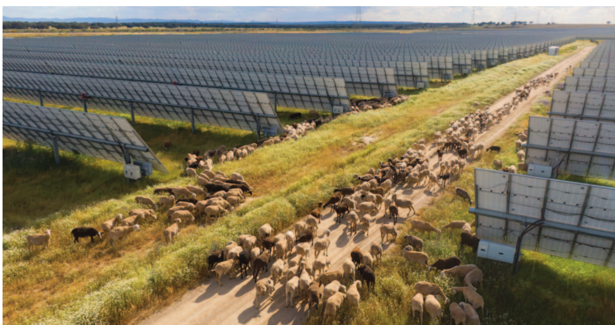
200 MW, Alcalá de Guadaíra, Seville, Spain.
